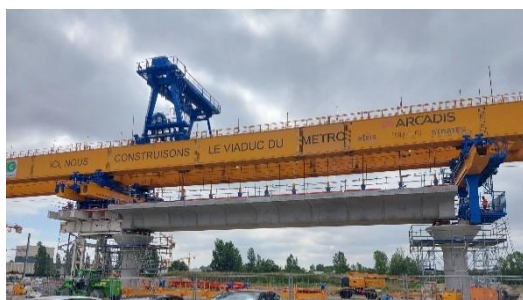
Poutre de lancement
